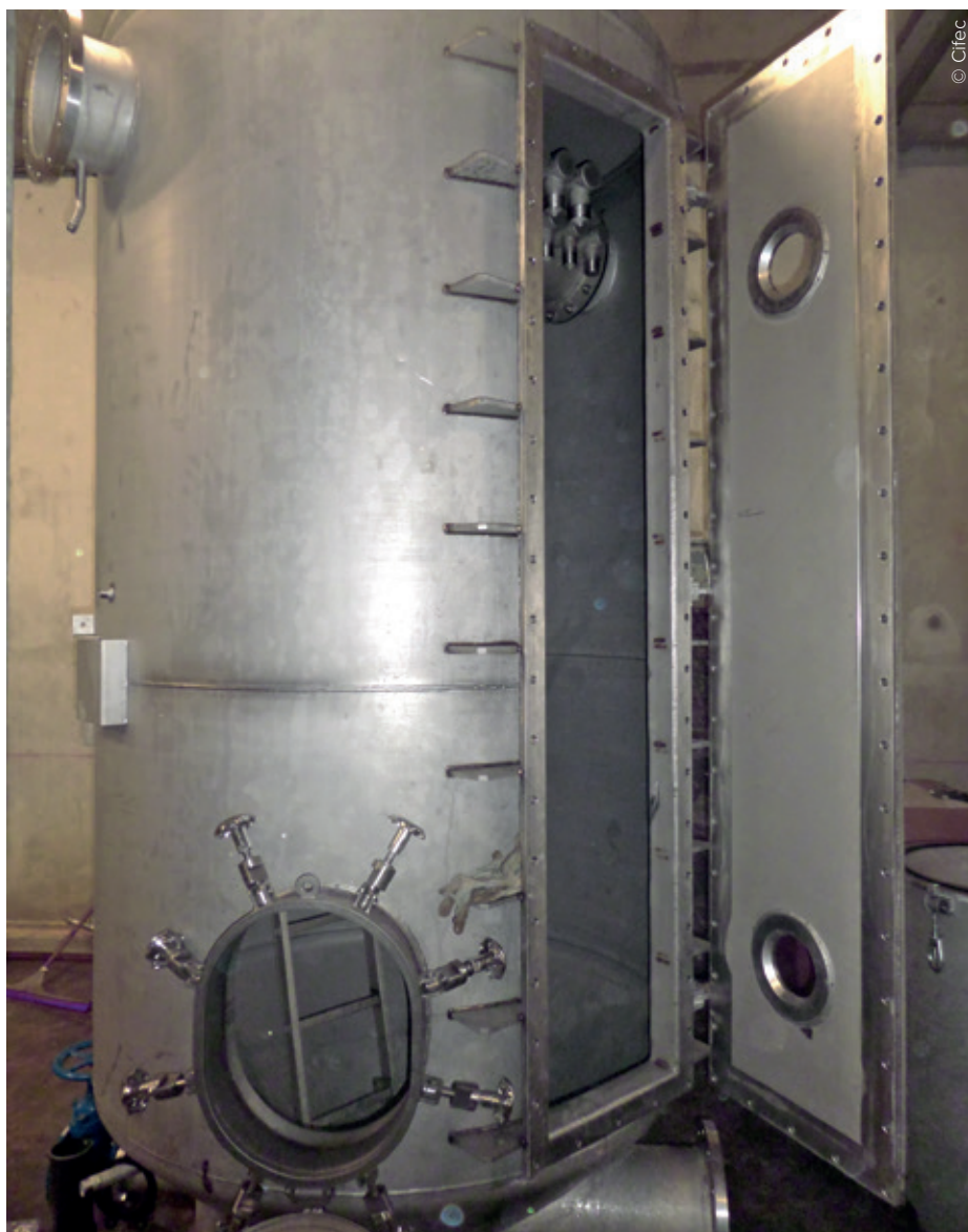
Les filtres Cifec sont équipés d'une vraie porte latérale, ce qui permet de sortir les plateaux pour les opérations de maintenance annuelle, voire de rentrer directement dans le filtre.
